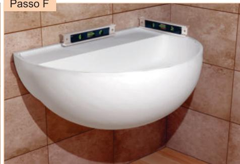
Com o auxílio de um nível, **nivele o lavatório** nas duas posições indicadas na foto. Após nivelado, realize um aperto final nas **porcas** (item 5).
